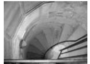
Les escaliers en colimaçon de la tour !
